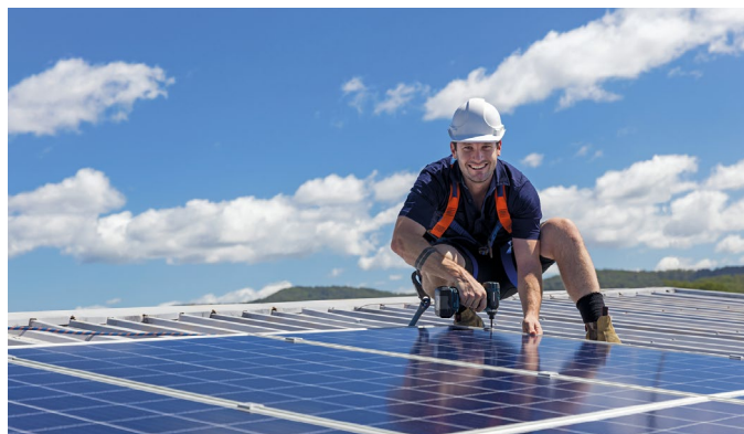
txn. Wer eine Photovoltaikanlage mit Batteriespeicher sein Eigen nennt, muss sich weniger Sorgen um steigende Strompreise machen. Und auch die Anschaffung wird vom Staat finanziell gefördert. Fotos: Plewa/txn
