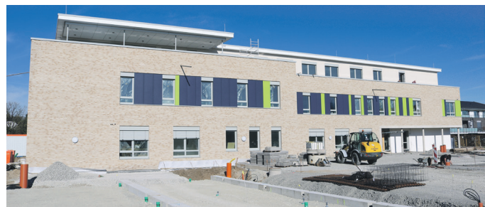
Die Bauarbeiten liegen im Zeitplan; der pünktlichen Eröffnung des Augenzentrums an der Osnabrücker Straße 49 am 22. Juni dieses Jahres steht daher nichts im Wege.
