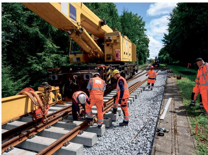
Gewaltige Maschine: Bei der Sanierung zweier Weichen in Wellendorf war ein 100-Tonnen-Schienenkran im Einsatz. Foto: Landkreis Osnabrück/Hermann Penttermann
